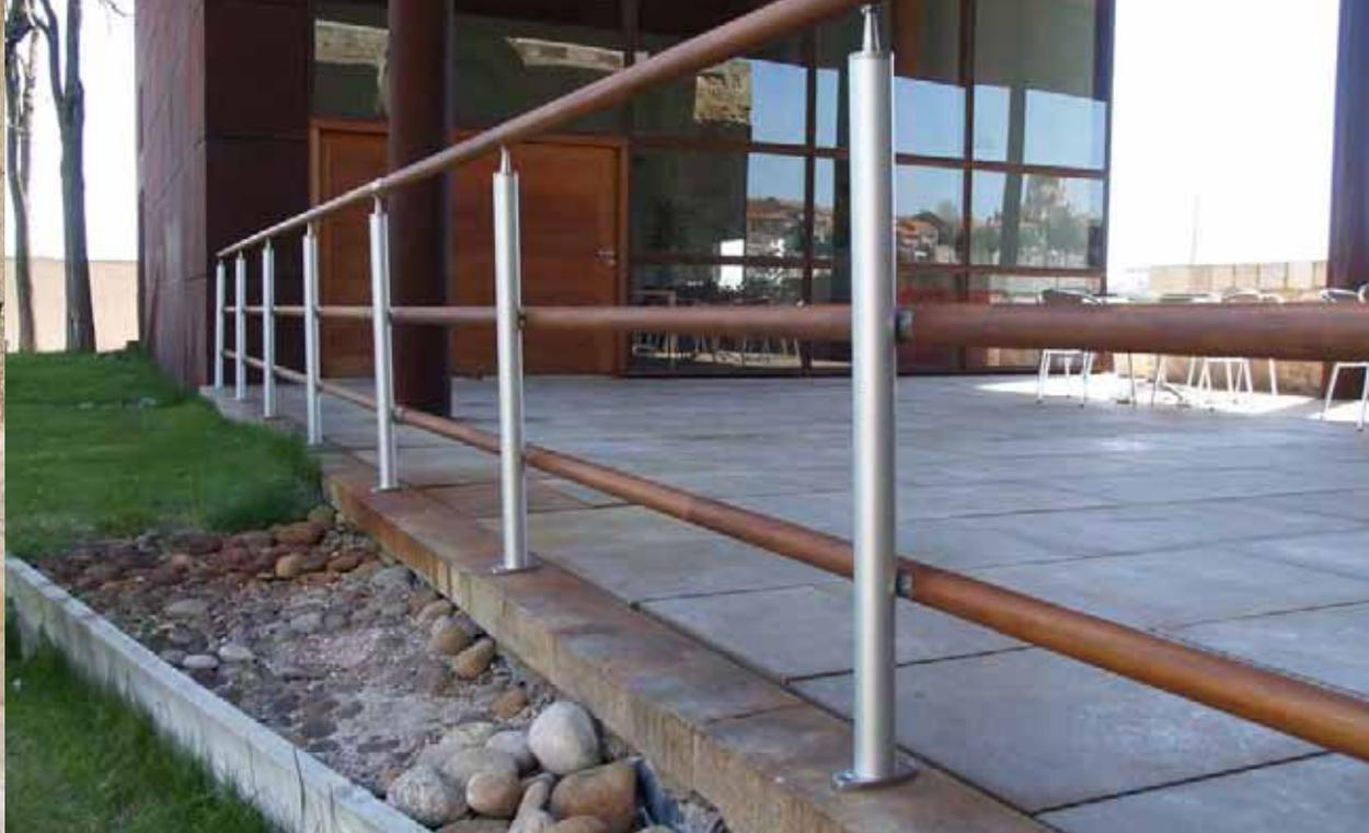
**Tub Metal** ist ein neues System aus Aluminium hergestellten Zäunen, Schutz- und Balkongeländern, Handläufen und Brüstungen, welche den hohen ästhetischen Anforderungen des Marktes entsprechen.
